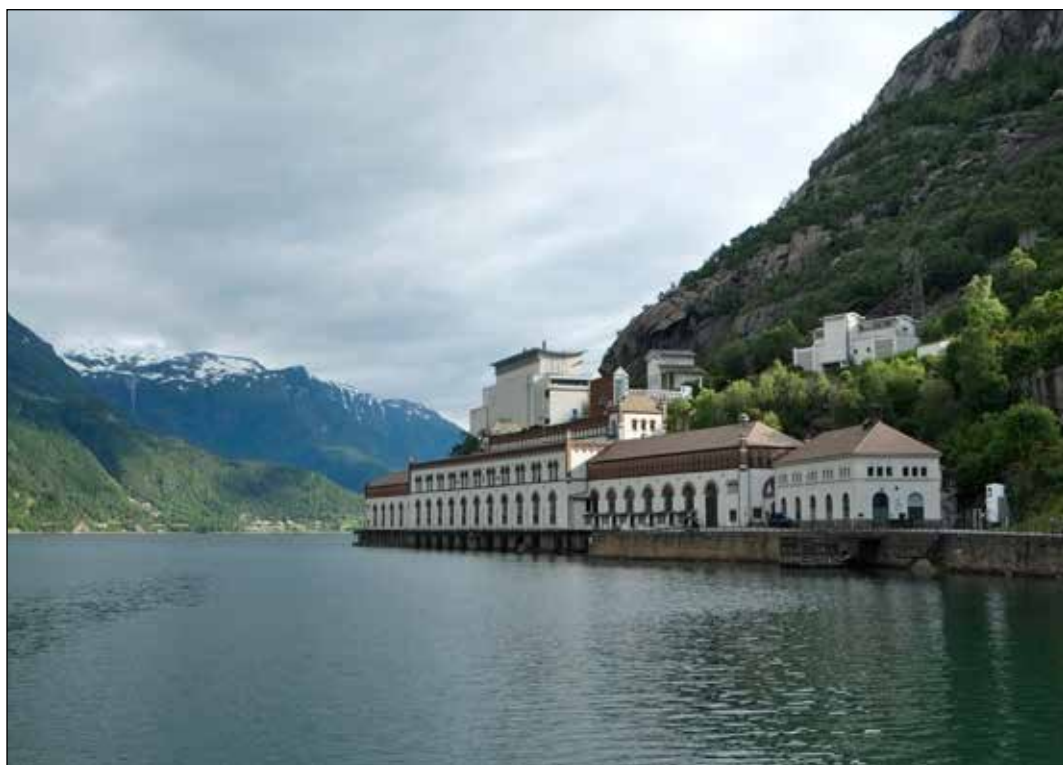
Fig. 5. Kraftstasjonen Tyssø I/Norsk Vasskraft- og Industristadmuseum. Foto: Unn Yilmaz, NVE.
