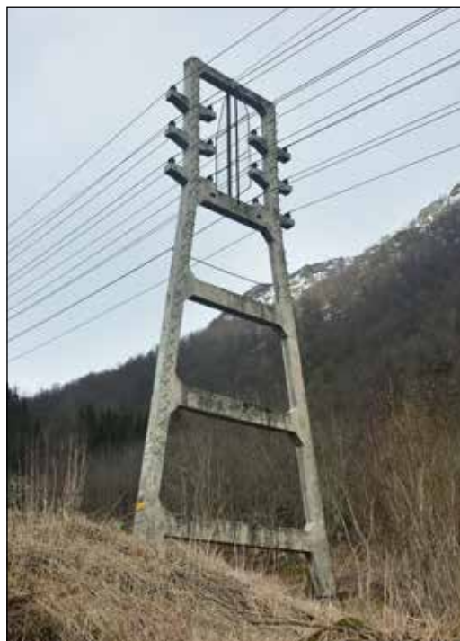
Fig. 8. En av pendelmastene i Glomfjord, som står på bevegelige ledd. Foto: Unn Yilmaz, NVE.
