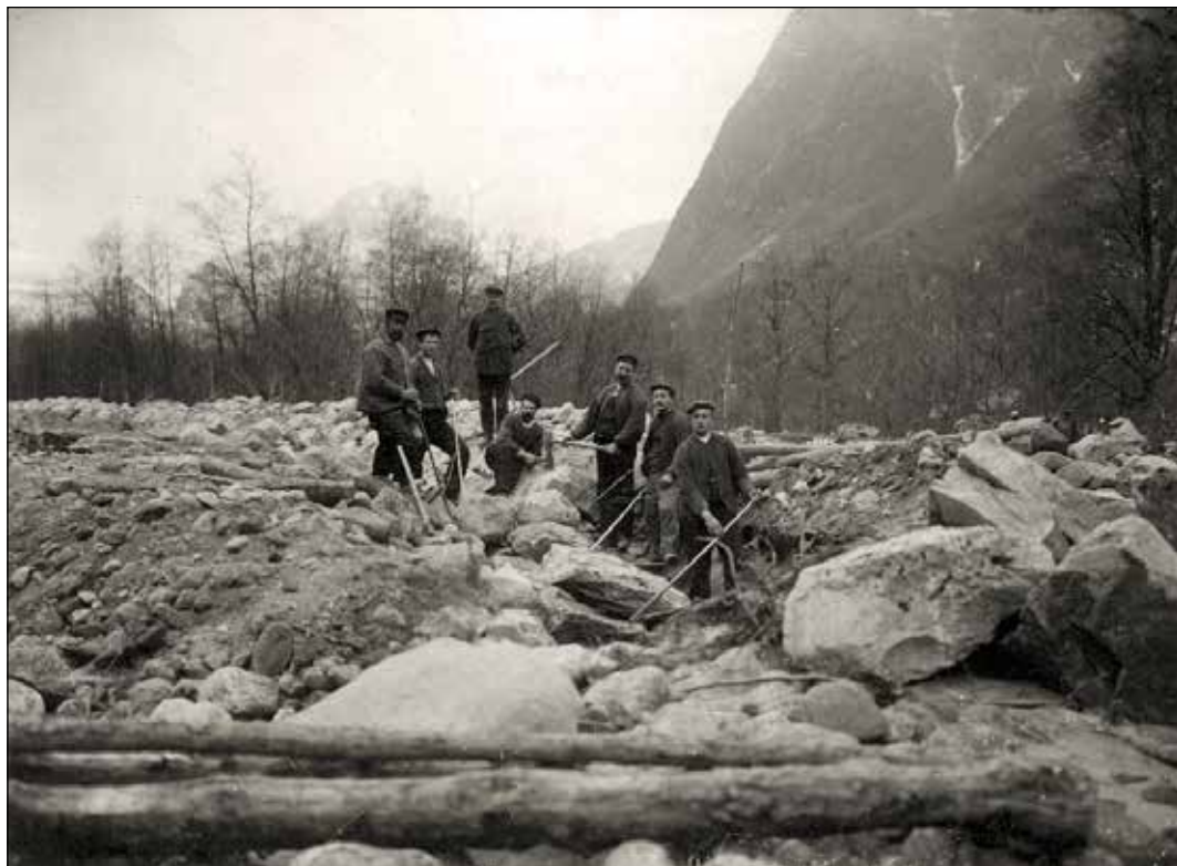
Fig. 2. Forbygningsarbeider etter flom i Nordfjord, 1908. Foto: NVE.
