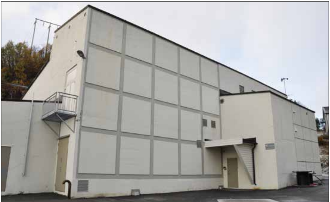
Fig. 10. Heggen transformatorstasjon. Foto: Sissel Riibe, NVE.
