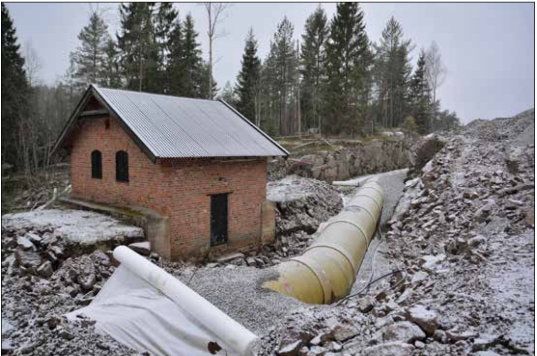
Figur 6. Bildet viser den nye rørledningen som legges rundt et av de opprinnelige ventilhusene slik at det kan bevares. Foto: E-CO/NVE.
