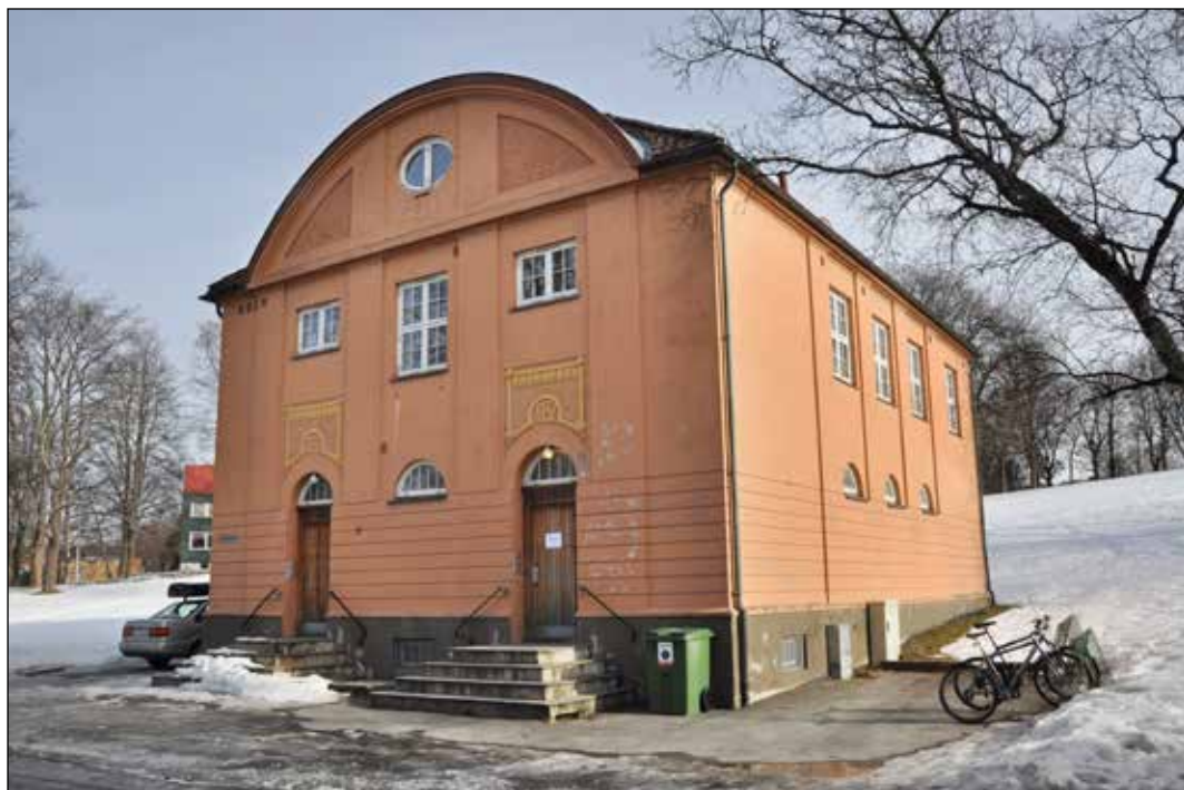
Fig. 4. Paulinelund 1 transformatorstasjon. Foto: Henning Weyergang-Nielsen, NVE.
