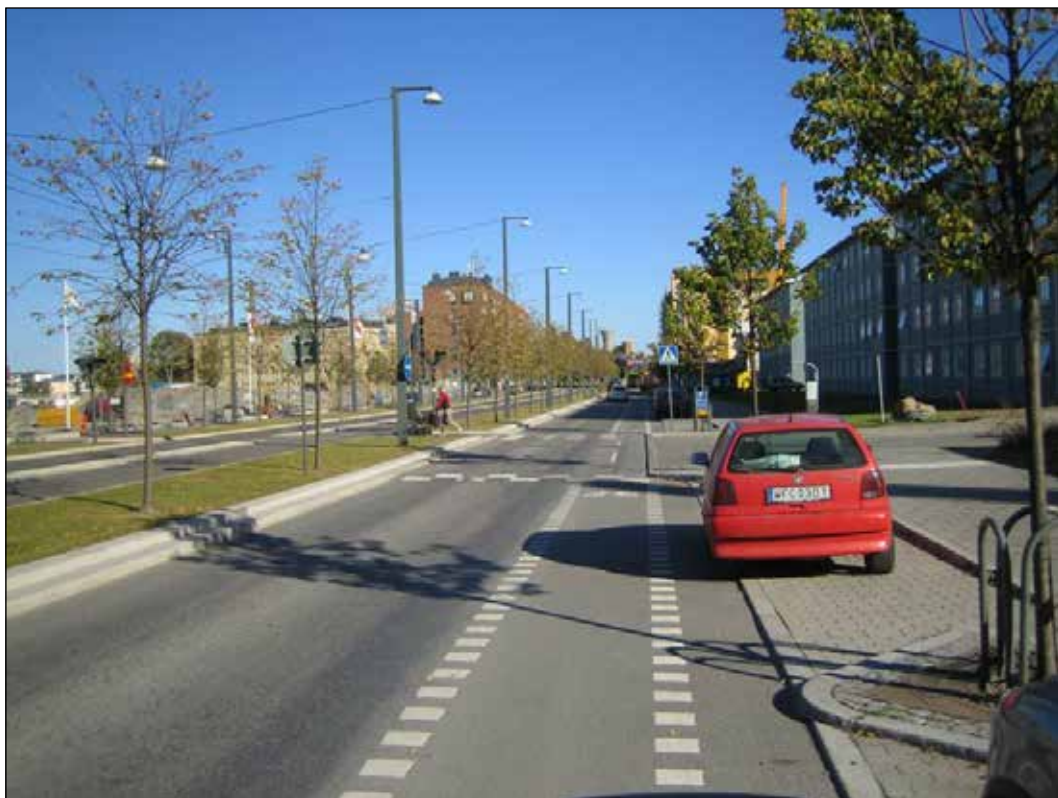
Figur 1. Gatetrær som står i midtrabatt uten tilgang på veivann har dårligere livsbetingelser enn gatetrær som mottar veivann med noe salt. Foto: Henrik Alm, Sweco.
