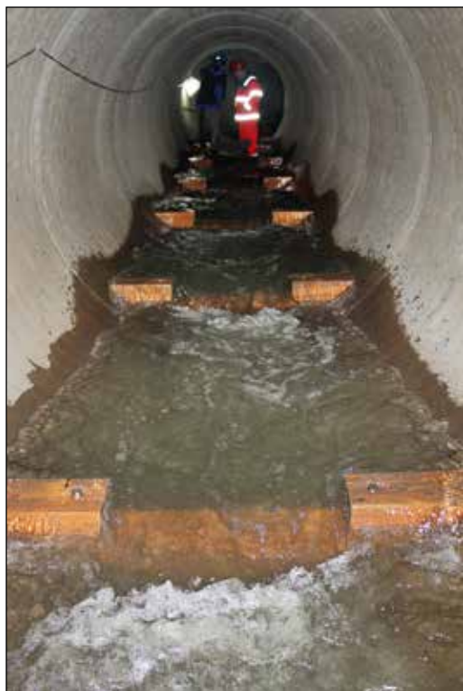
Figur 5. Terskler og bygging av fisketrapp i Mærradalsbekken. Foto: Heidi Kristensen, Bymiljøetaten.
