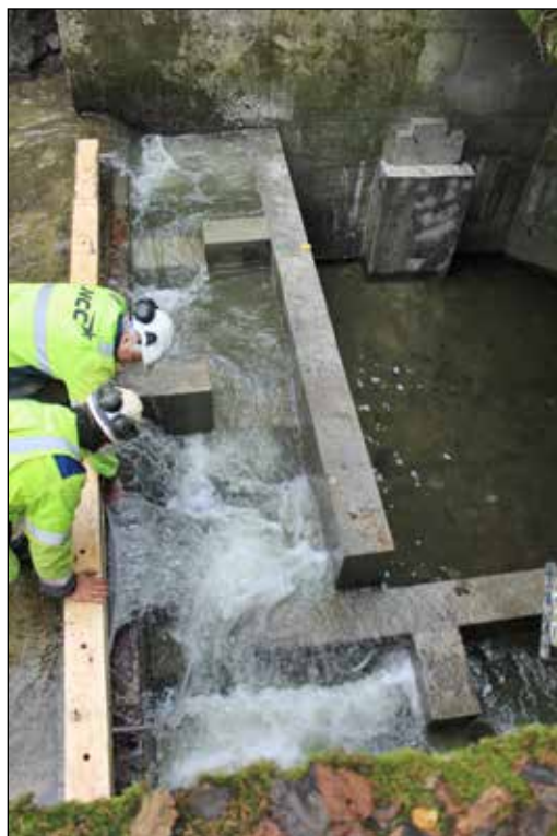
Figur 5. Terskler og bygging av fisketrapp i Mærradalsbekken. Foto: Heidi Kristensen, Bymiljøetaten.
