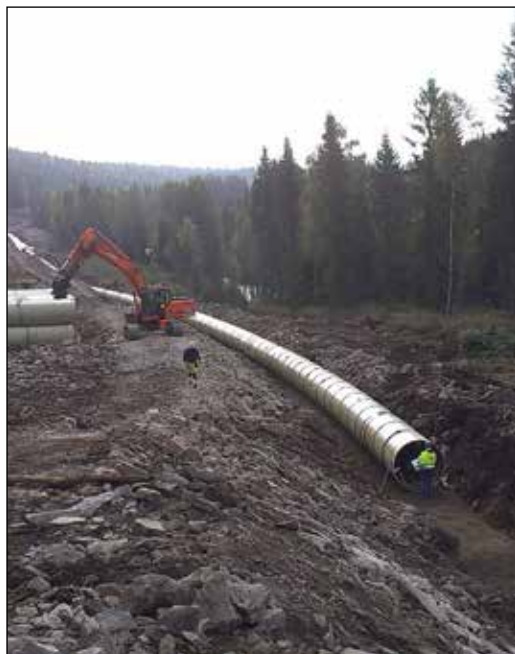
Anlegg av ny rørgate (E-CO).
