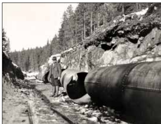
Fra anlegg av rørgata for Hammeren kraftverk 1889-1900 (Byarkivet).
