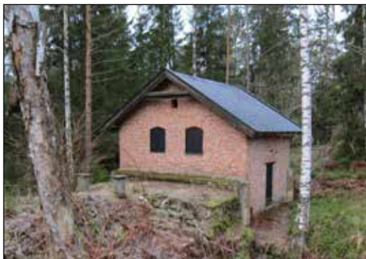
Øvre og nedre ventilhus (E-CO).
