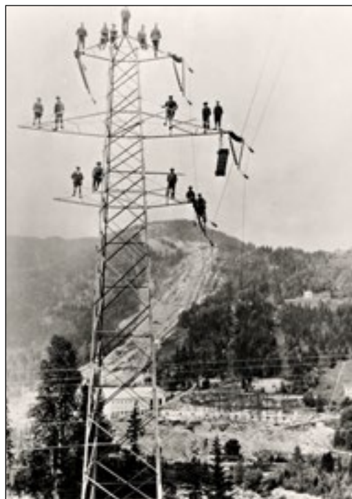
Bilde 3b. Nore. Utbygging av master (Statkraft AS)
