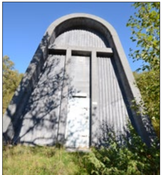
Bilde 8. Lukehus i plasstøpt betong med avrundet møne ved Ulla-Førreanleggene. (Foto: Erling Nystad).
