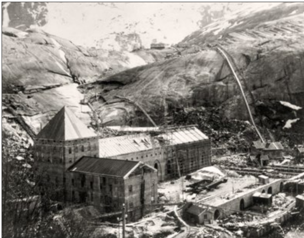
Bilde 1. Glomfjord kraftverk under konstruksjon (Statkraft AS).
