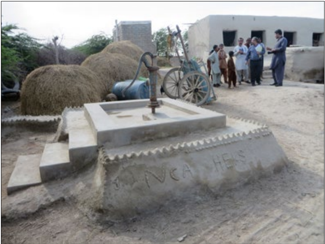
Foto 2. Kirkens Nødhjelps installerte denne sugehåndpumpen på en rund 60 cm høy plattform for å forhindre at oversvømmels vann kan trenge inn i brønnen. Foto ble tatt i Naushera Feroz District, Sindh-provinsen, Pakistan. (Kilde: Manfred Arlt).
