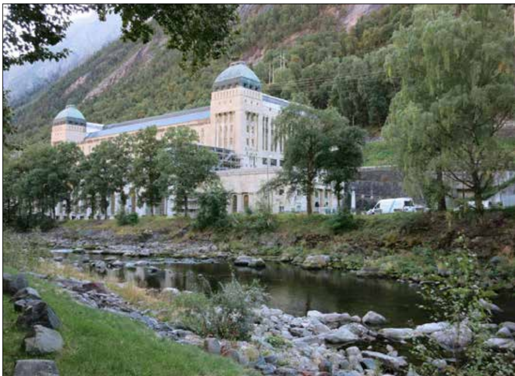
Såheim kraftstasjon og den regulerte Måna hvor det er gjennomført en rekke miljøtiltak ut fra vår tids standard. Elvestrekningene mellom kraftanleggene binder verdensarvområdet sammen til en helhet (Foto: P.E. Faugli, NVE 2013).
