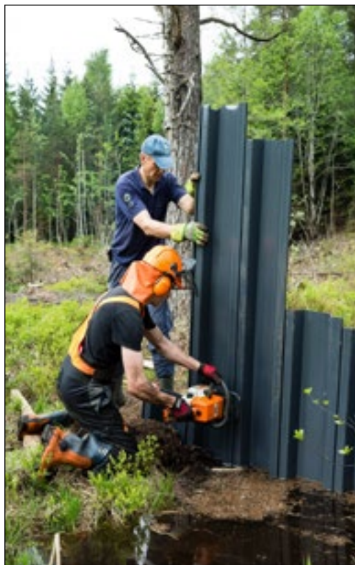
Figur 8. Justering av høyden på demningen kan gjøres med sag. Motorsag viste seg imidlertid å være et litt for grovt redskap som lett skader spuntene ved kapping. Bruk av stikksag eller håndsag er bedre. Foto: Fylkesmannen i Oslo og Akershus.
