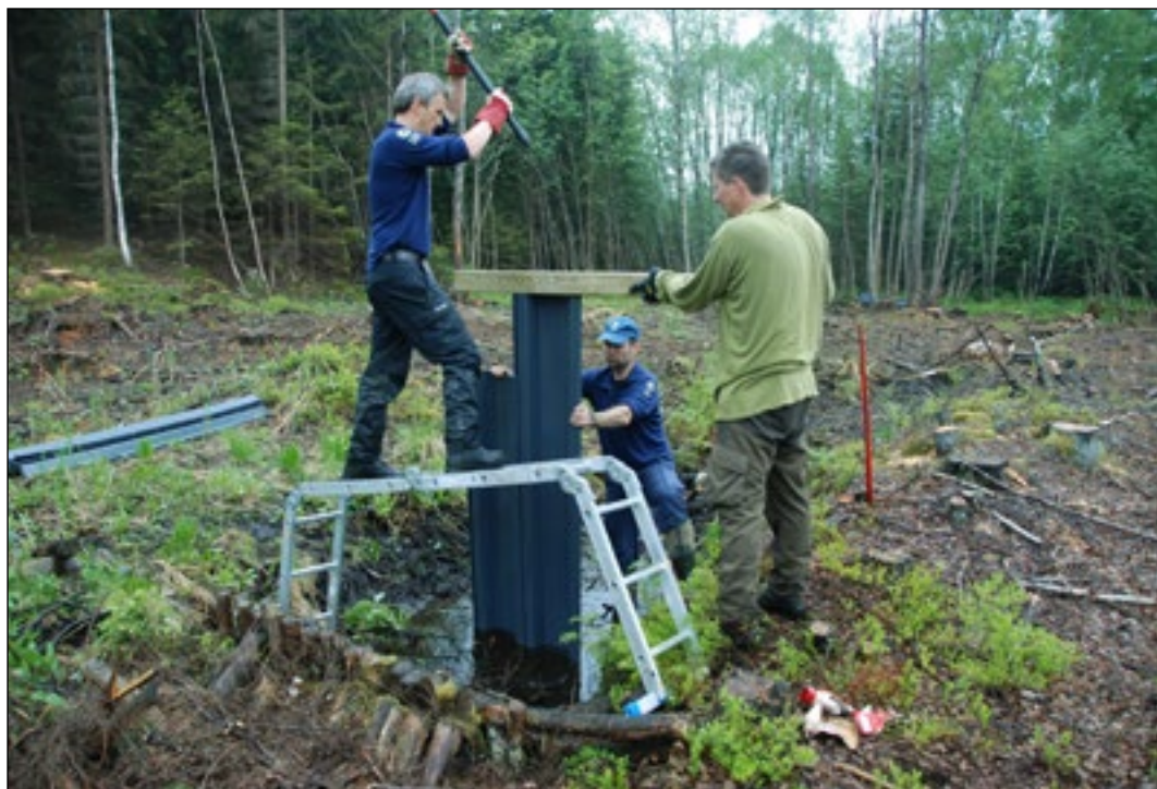
Figur 6. Plastsputen slås ned i myra med gummislegge og anslag av tre. Foto: Fylkesmannen i Oslo og Akershus.
