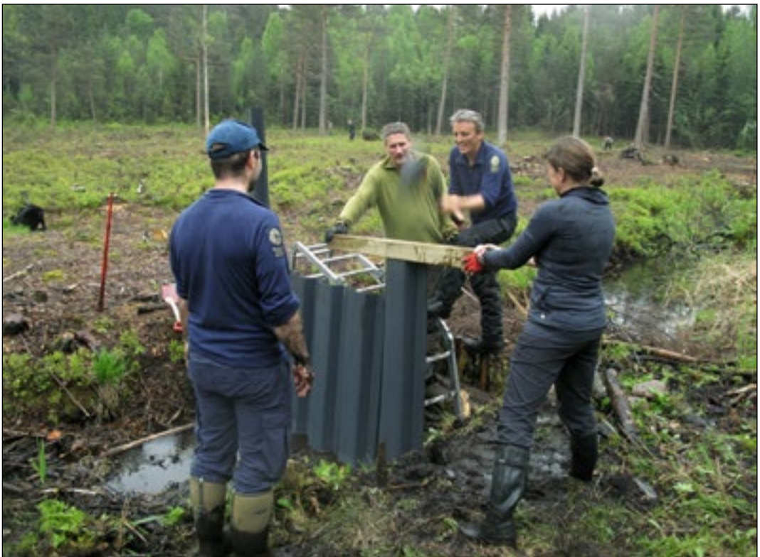
Figur 5. Montering av plastspunt. Foto: Fylkesmannen i Oslo og Akershus.
