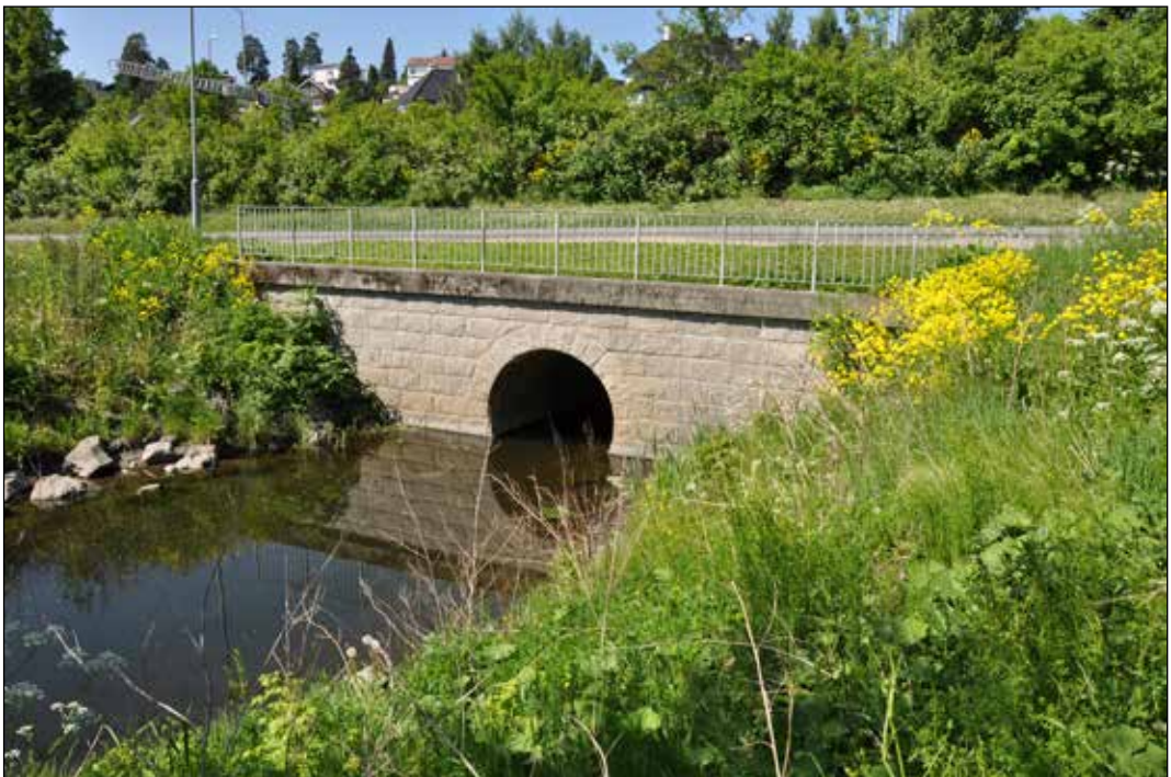
Figur 2: Kulvert hvor Holmenbekken renner inn i Smestaddammen. Utløpet fra tunnelen er inne i kulverten (Foto: Vianova Plan og Trafikk).
