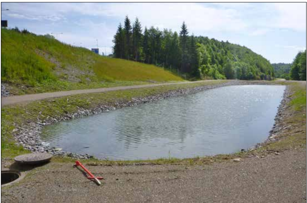
Figur 2. Rensedbasseng ved E18 Langangen i Telemark. Langstrakt basseng med fast vannspeil for fordøyning og rensing av veivann. For- og hovedbasseng er bygget sammen til en integrert bassengenheter (foto: COWI).
