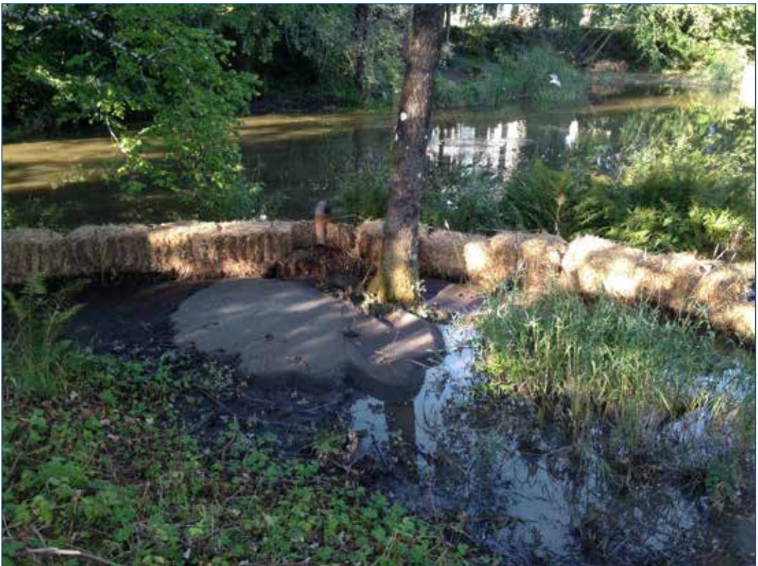
Bilde 6. Avvanning av slam ved hjelp av høyballer
