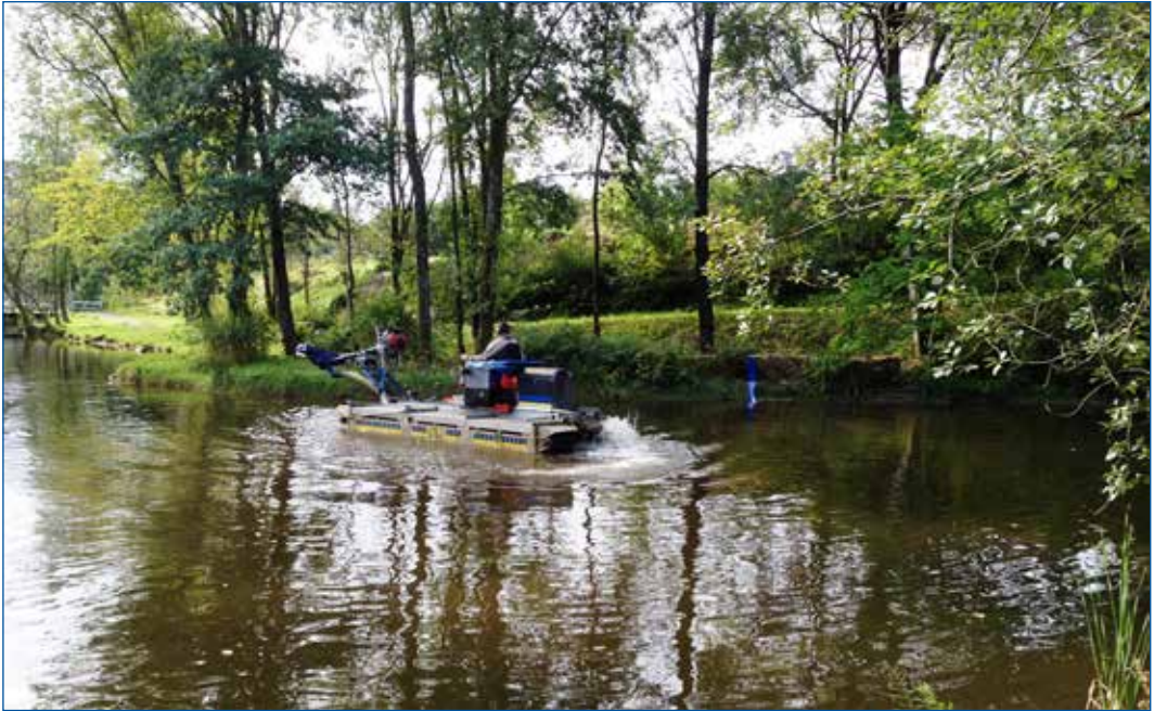
Bilde 5. "Støvsuging" ved hjelp av amfibiekjøretøy.
