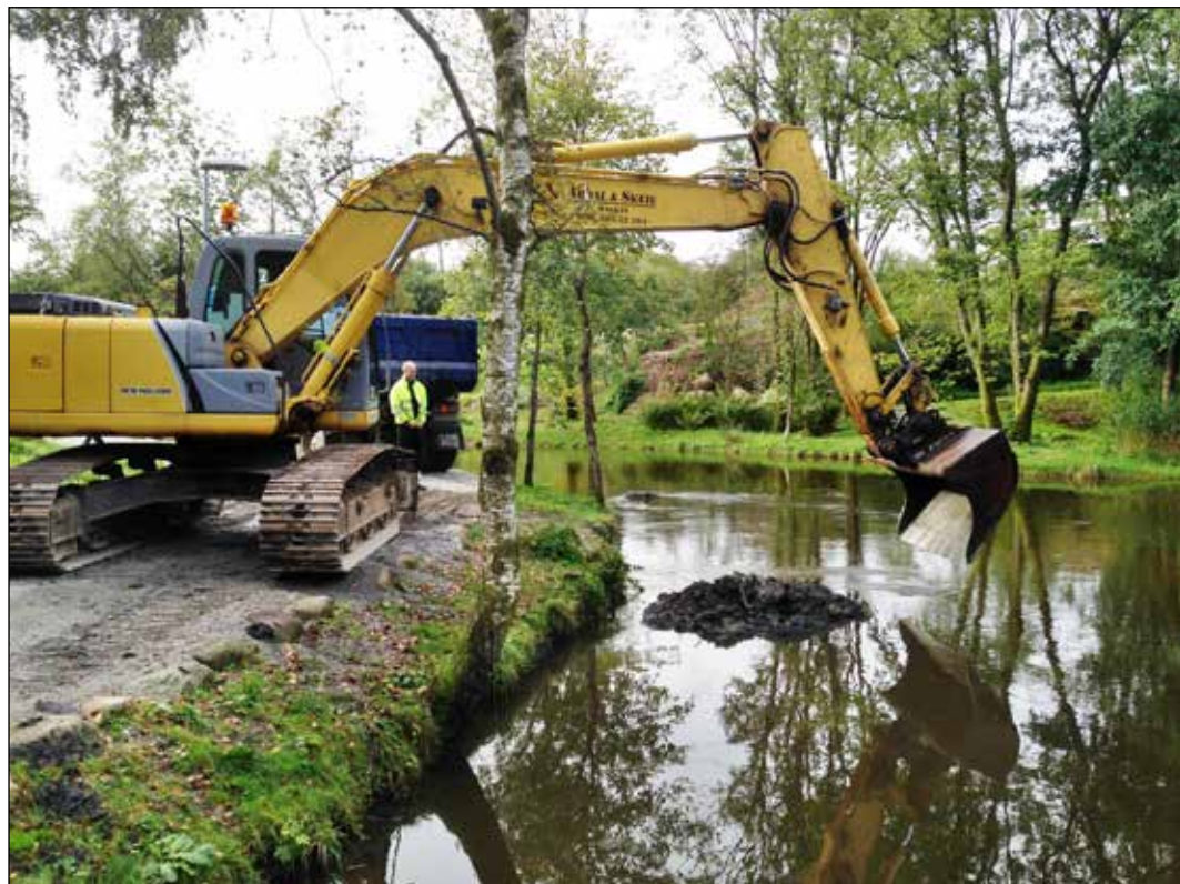
Bilde 4. Tømning av slam ved innløpet.
