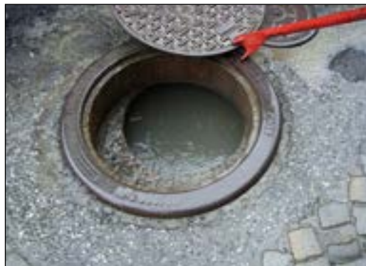
Figur 3. Venstre: reparasjon av drikkevannsledning med brudd. Ledningen er omgitt av skittent vann. Høyre: felleskum som er fylt med avløpsvann/overvann.
