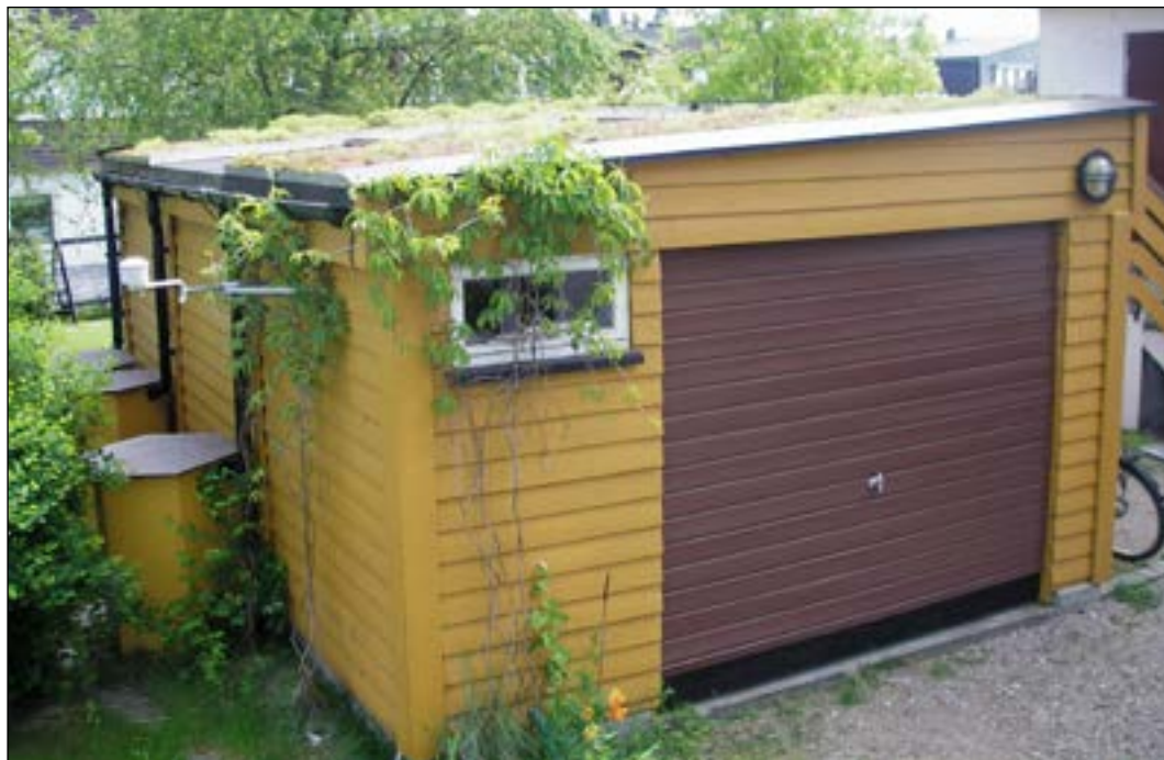
Figur 1. Forsøksfeltet L34b er en garasje der vann ledes fra 3 takflater til isolerte vandunker.
