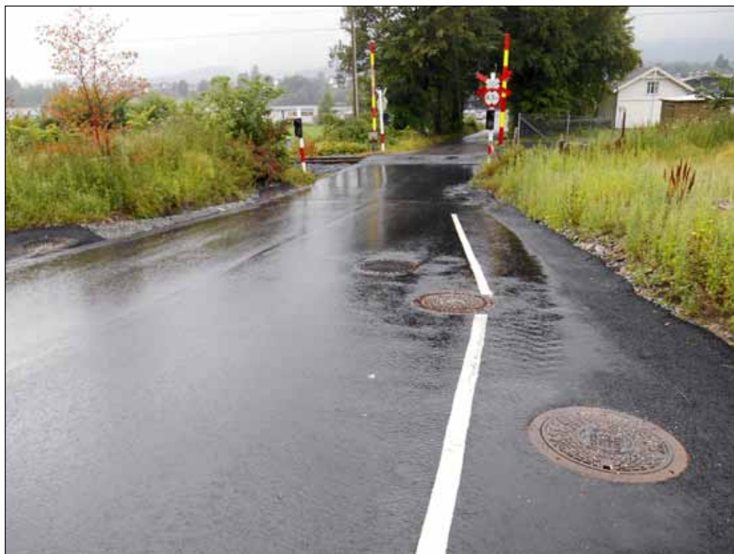
Figur 7. Oppstrømskryssingen av jernbanen må alt overvann fra veien føres ned i rørledning. I dette tilfellet skal senket vegbane og fire vegsluk sørge for at overvannet ikke skader jernbaneovergangen. Borgestadbakken i Skien.
