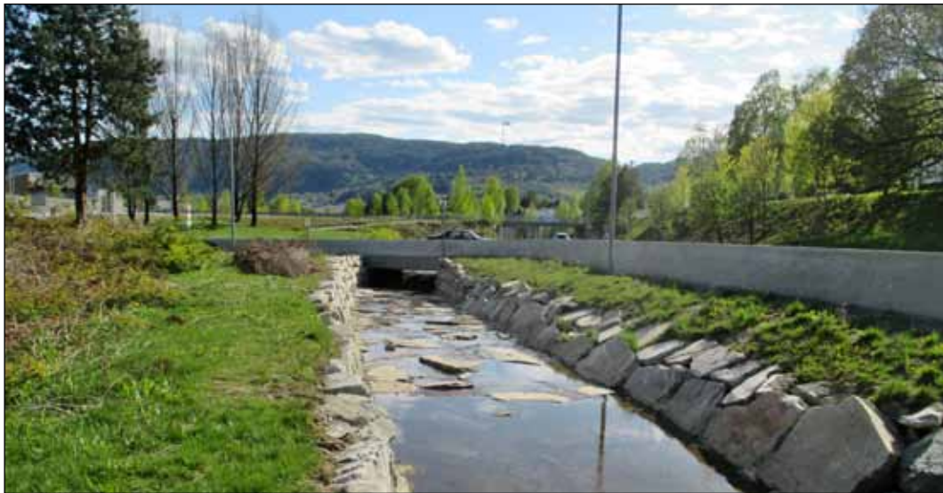
Figur 3. Utbygging av et område medfører gjerne at flomtoppene blir høyere. Bekker i løsmasse må da sikres mot erosjon. Setrebekken i Notodden (kulvert under FV 360 ved krysset med E134)
