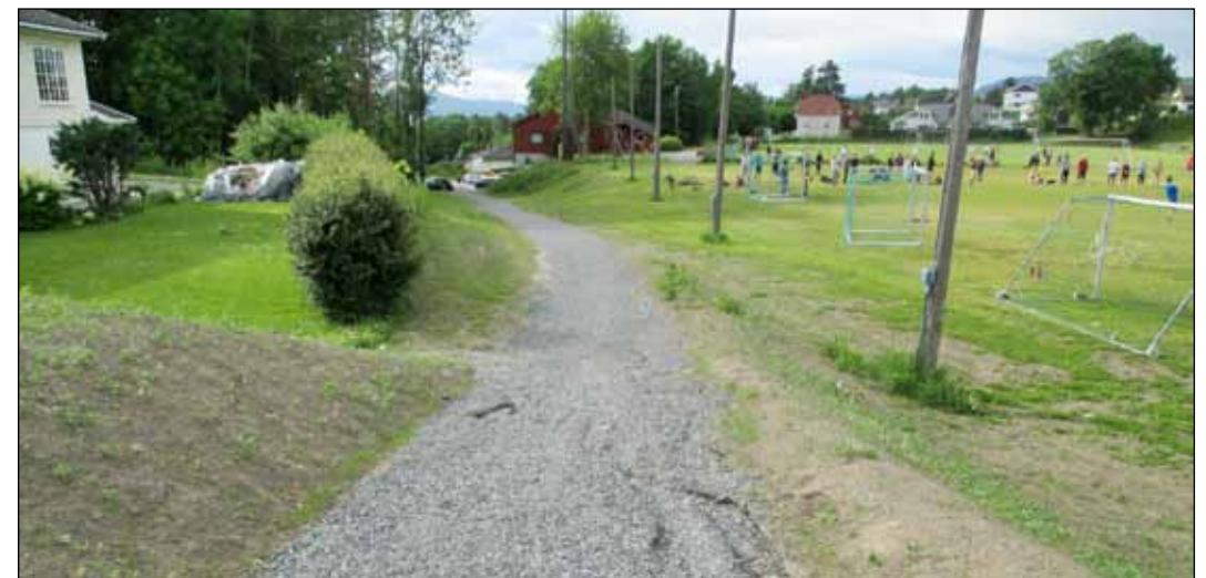
Figur 6. Denne gangvegen er lagt i et langt søkk i terrenget, og den er flomveg for områdene ovenfor. Samlet lengde på denne flomvegen er om lag 1,3 km. Fotoet viser en strekning høyt oppe i flomvegen, og her er det nok at flomvegen gruses. En må imidlertid regne med at kraftig flom vil skade den gruslagte strekningen. Skauenvegen, Skien kommune.
