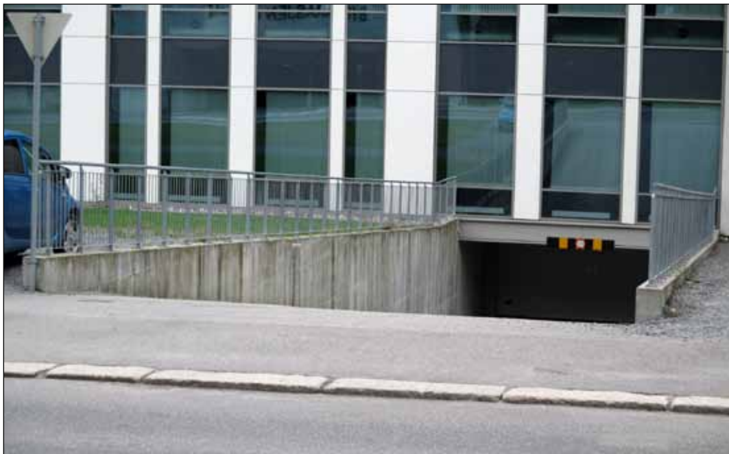
Figur 4. Fortauskant hindrer at overvannet fra vegen skal renne ned i parkeringskjelleren. Det er lett å fortrenge kunnskapen om overvann, og her ble høydeforskjellen mellom fortauet og rennesteinen økt først etter pålegg fra kommunen. Kongens gate i Skien.
