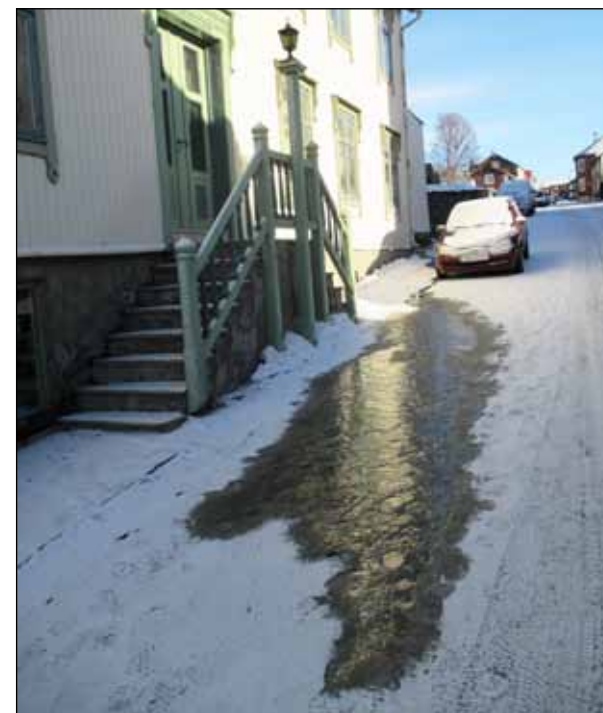
Figur 1. Takvannet føres ut på bakken. Dette er vanligvis en god løsning. Men i dette tilfellet dekker smeltevannet fra hustakene en for stor del av gatebredden, slik at det kan bli farlig for fotgjengerne når smeltevannet fryser til is utpå kvelden.
