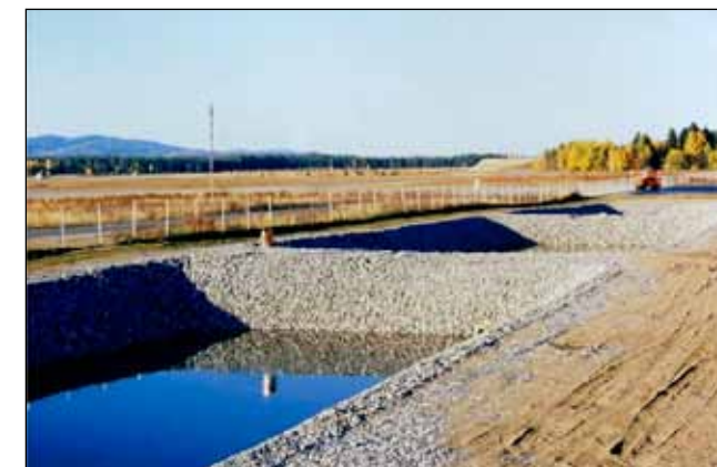
Bilde 2. Infiltrasjonsbasseng for oppumpet grunnvann i forbindelse med anleggsarbeidene (mot vestre bane).
