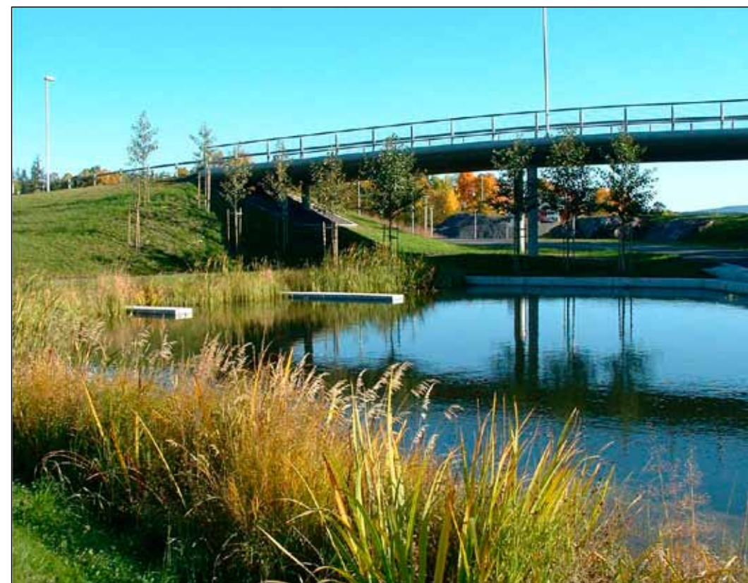
Bilde 6. Oppsamling og behandling av avrenning fra vei i dammer – estetiske krav.
