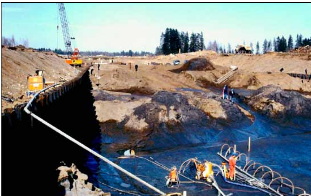
Bilde 1. Grunnvannsenkning i forbindelse med bygging av jernbanekulverten under flyplassområdet.
