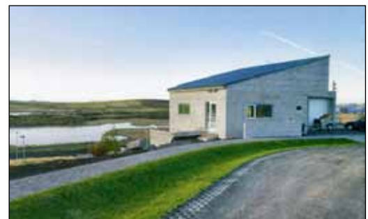
B) Swale langs en gate og gangveg
