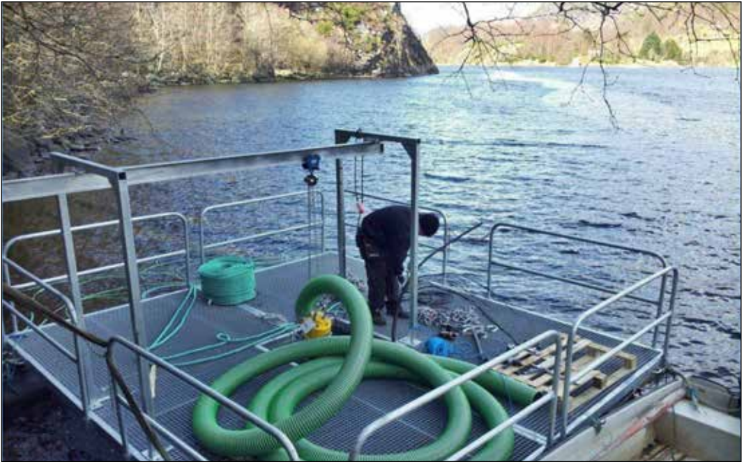
Figur 2. Flåten på plass før oppstart, med pompa påmontert 25 cm diameter slange.
