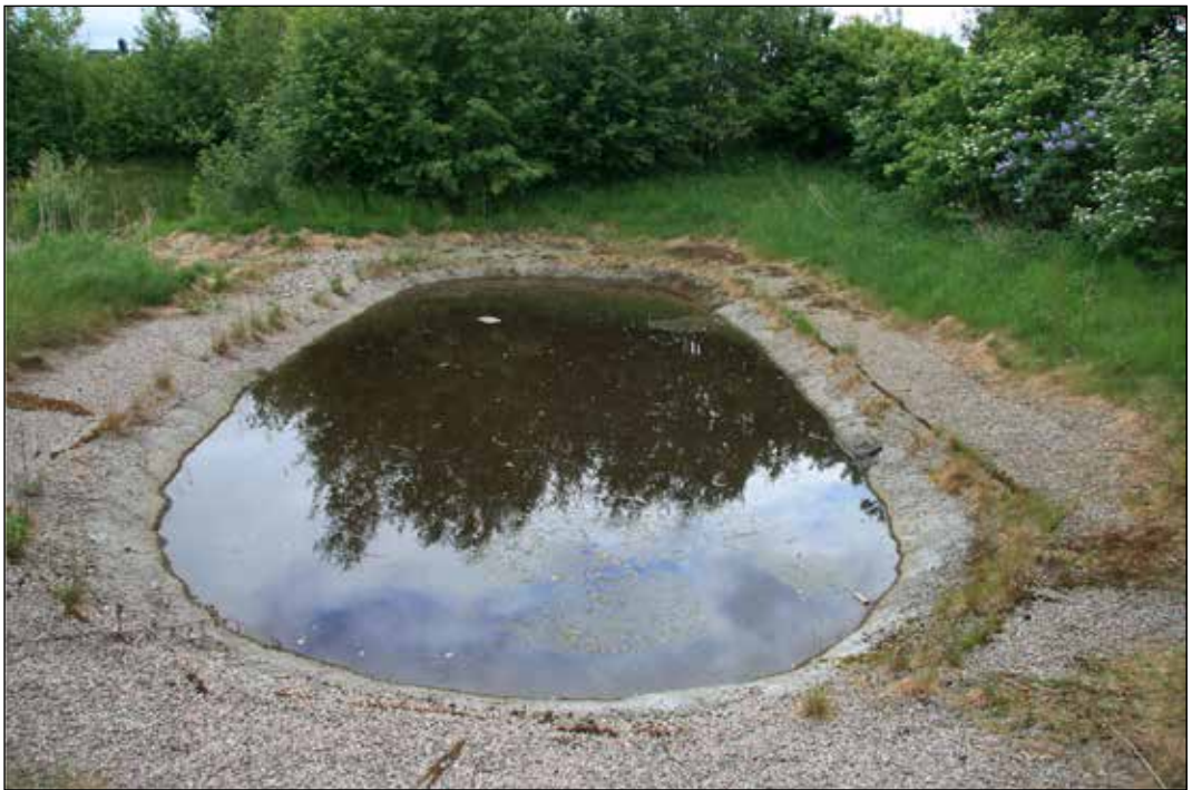
Figur 2. Forsedimenteringsbasseng til Bjørnstadgrenda rensedbasseng ved E6 i Sarpsborg kommune. Et typisk eksempel på rensedbasseng med permanent vannspeil.
