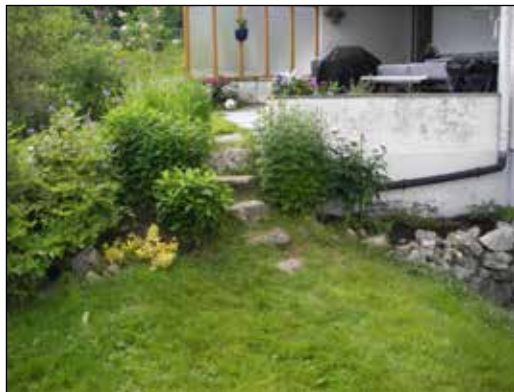
Bilde 2. Takrenneutkastet er forlenget inn i blomsterbed, med utløp i plenkantene.
