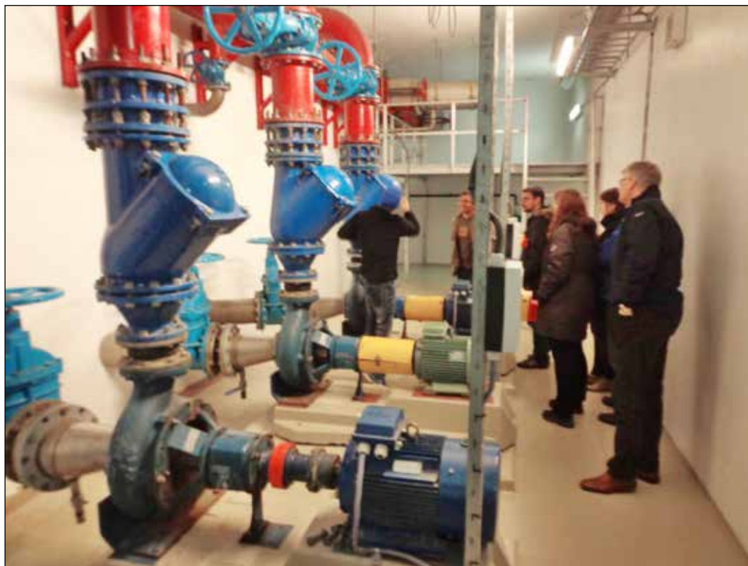
Studentene vurderer tre parallellkoblede pumper og særlig de store tilbakeslagsventilene, samt utførelsen i forhold det som er forelest. Stemmer teori og praksis?
