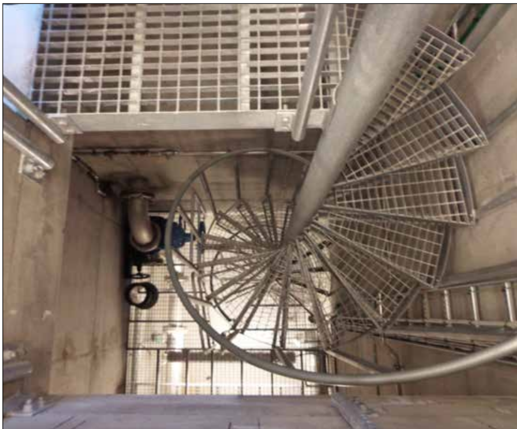
Tollbua avløpspumpestasjon er meget dyp.
