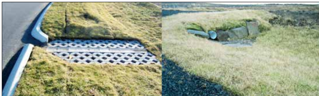
Figur 4a og b. a) Detalj rundt et konsentrert innløp langs siden. Foto: Sveinn T. Thorolfsson. b) Detalj rundt et konsentrert innløp oppstrøms. Foto: Tore Leland.
