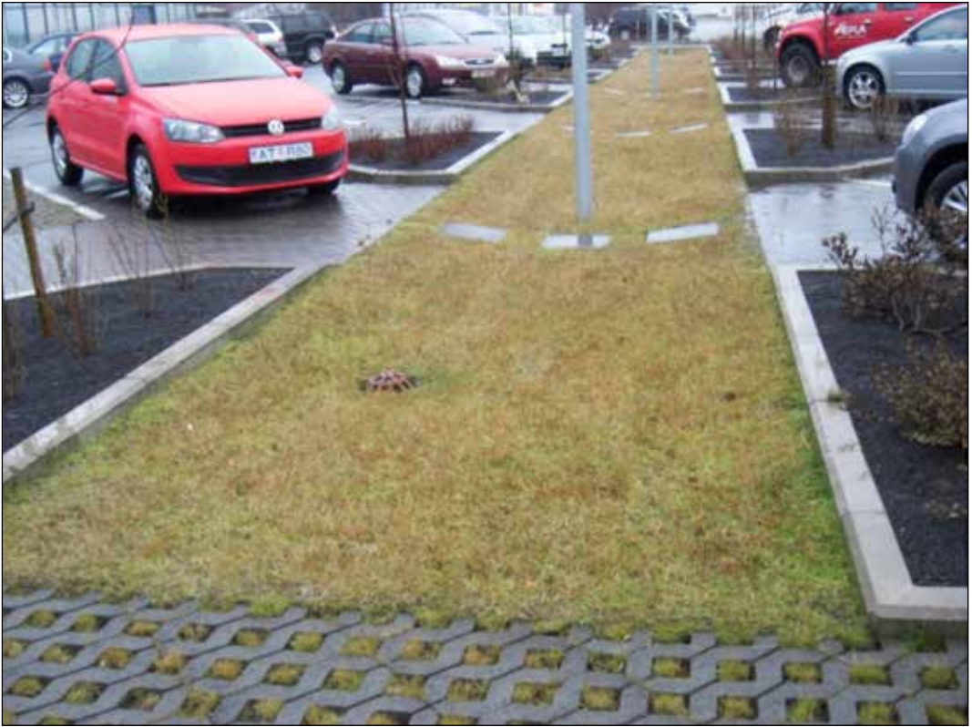
Figur 2. Ettermontering av en gresskledd vannveg på en parkeringsplass i Reykjavik, Island.
