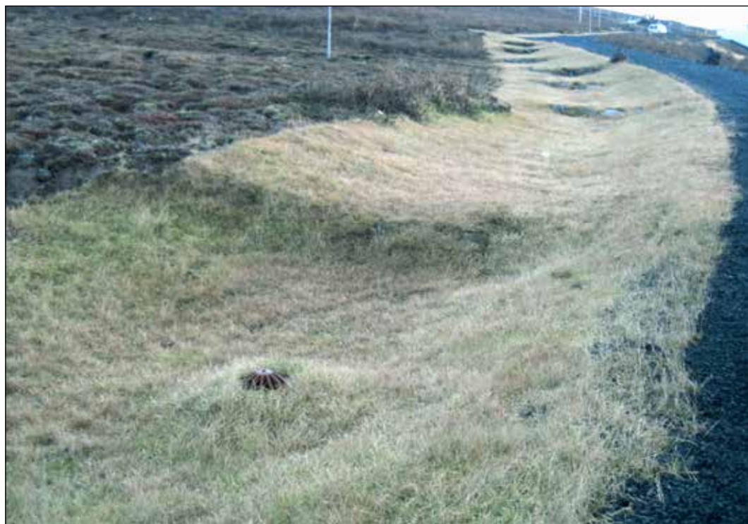
Figur 1. Gresskledd vannveg på Urridaholt, Island. Tiltaket kombinerer bortledning av vann fra med størst mulig forsinkelse og fordrøyning underveis. Hevet utløp over bunnivå øker fordrøyningen. Foto: Tore Leland.
