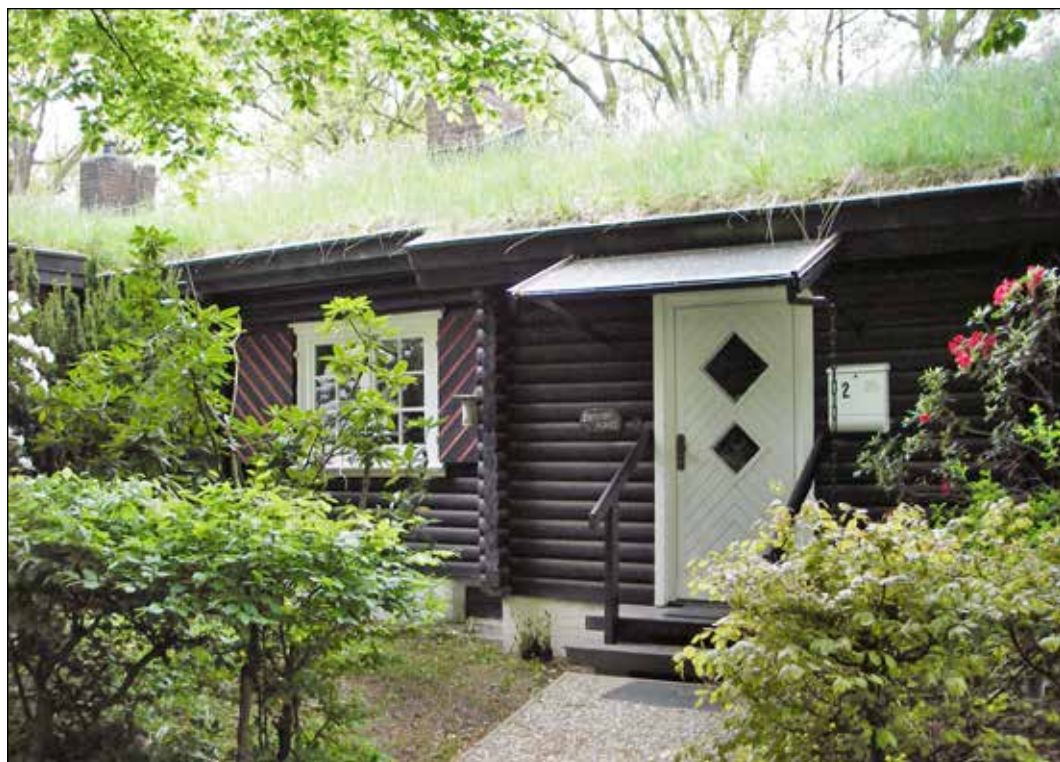
Foto 1. Gress på taket etter norsk tradisjon; i Tyskland.
