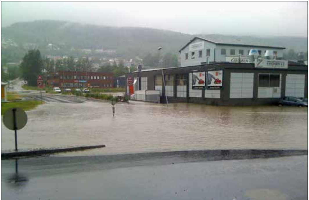
Bilde 1. Oversvømmelse i krysset Collettsgate/Bjørnstjerne Bjørnsonsgate på Strømsø 5. juli 2009 (foto: Tor E. Thorsteinsen).
