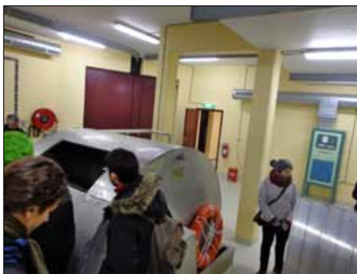
Roterende sil i silanlegget med studenter på befaring.
