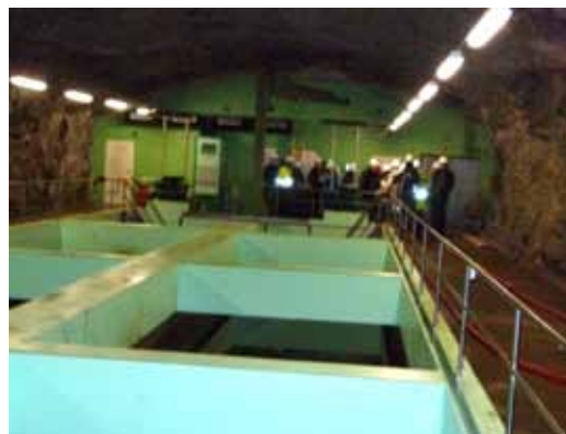
Den gamle silhallen fra 1964. Den er nå museum. Mange studenter som har studert VA-teknikk ved NTH, har besøkt denne silhallen.
