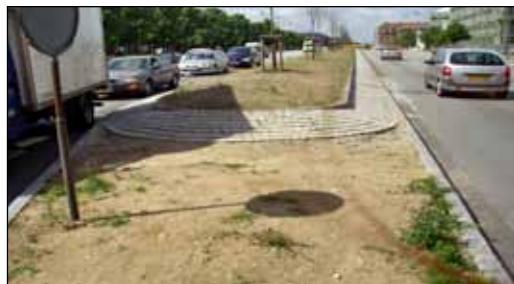
Figur 4. Viser forhøyet rabatt for bedre overlevelse av urban vegetasjon under påvirkning av vegsalt (Pedersen og Holgersen 2006).
