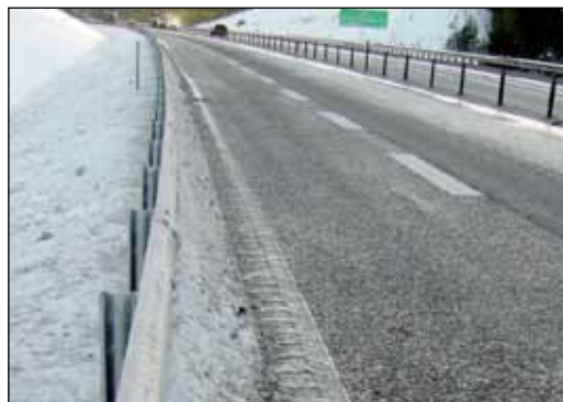
Figur 3. Viser vegstrekning med oppsamling av avrenning av salt ved hjelp av kantstein og sluk (Lundmark et al. 2007).
