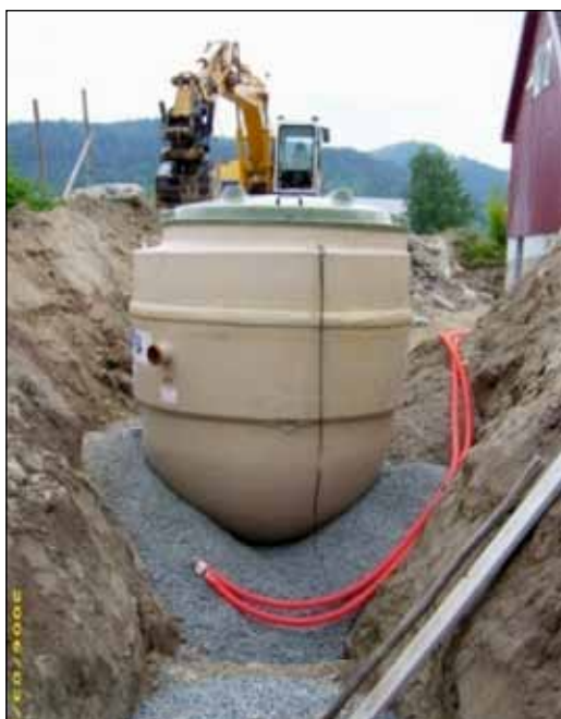
Bilde 2. Utløpsarrangement for rensed avløpsvann.
