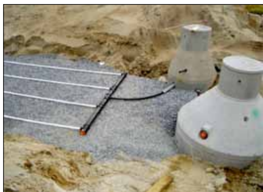
Bilde 1. Infiltrasjonsanlegg under bygging (Foto: Jørgen Ove Myrre). Bildet viser slamavskiller nærmest, pumpekum / støtbelaster, manifold for trykkfordeling og infiltrasjonsrør. Over dette skal det legges pukk, duk og tilbakefylling med stedlige masser. I dette tilfellet er det valgt betongkummer uten drenering omkring. Dersom det dreneres under tanker, må infiltrasjonsområdet skilles fra disse med tette masser eller større avstand.
