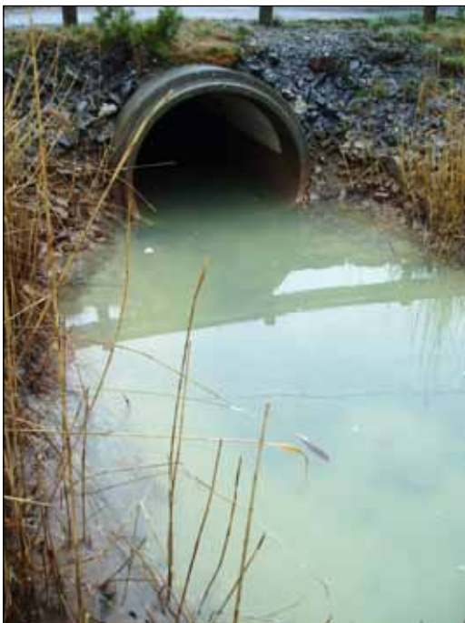
Figur 6. Metallutfelling og slamproduksjon der avrenningen fra M15/16 renner ut i Kaldvellfjorden.
