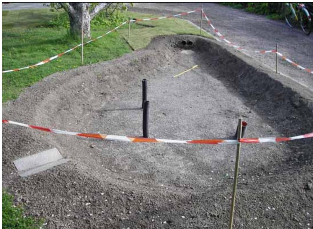
Figur 4. Ferdig regnbed uten planter (NB21). Vann i innløpet faller på en skiferhelle for å hindre erosjon. Utløpet er sikret med 2 skiferheller i V-form. Nedløpsrør til strupet drenerør øker regnbedets evne til å tilbakeholde overvann.
