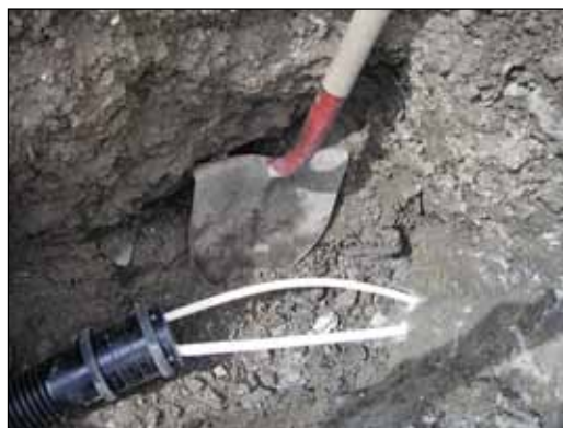
Figur 6. Drens rør i NB21 er strupet for redusert påslipp til kommunalt nett.
