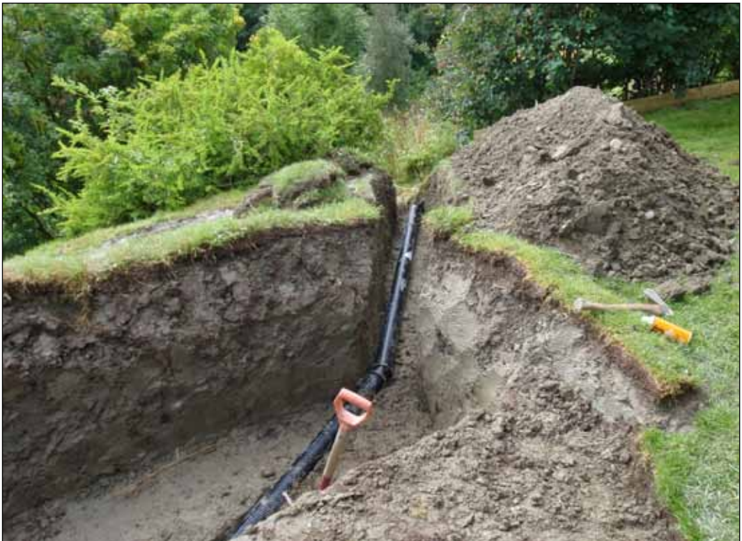
Figur 5. I H8 ble ikke hele filteret skiftet ut, fordi regnbedet ble anlagt manuelt. (foto: R.A. Grande).
