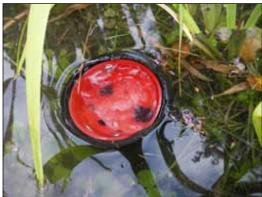
Figur 7. Nedløpsrør til strupet drenerør i NB21 utnytter porevolumet i filteret når infiltrasjonshastigheten er for lav.
