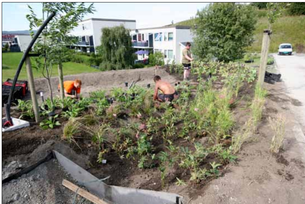
Figur 8. Beplantning av RIS. Regnbed er artsrike anlegg tilpasset lokalt klima (foto: A. Ekle fra innløpet).
