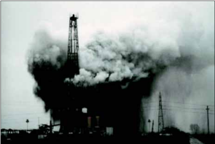
Figur 1. Ukontrollert oljeutblåsing (Trecate 1994). Foto: Politecnico di Torino (POLITO).
