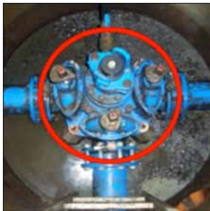
Figur 3 og 4. Tidligere ble vannverksarmatur forankret i kumvegg. Ved prefabrikkerte løsninger er forankringen flyttet til senter kum.
