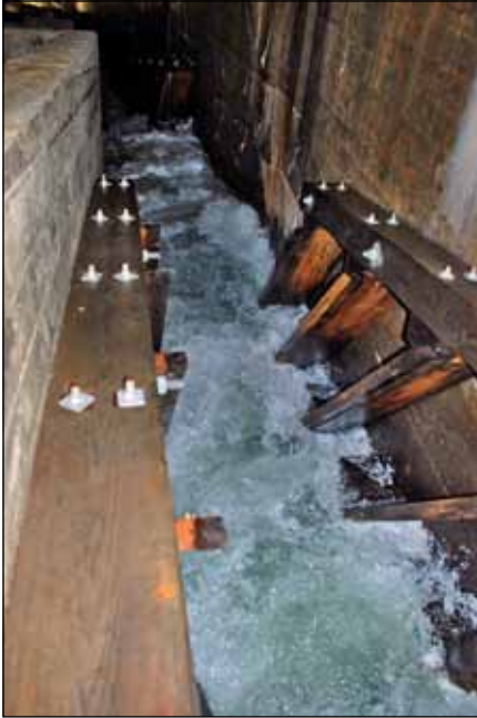
Bilde 1. Motstrømstrapp ved Hunderfossen kraftverk i Gudbrandsdalslågen.
