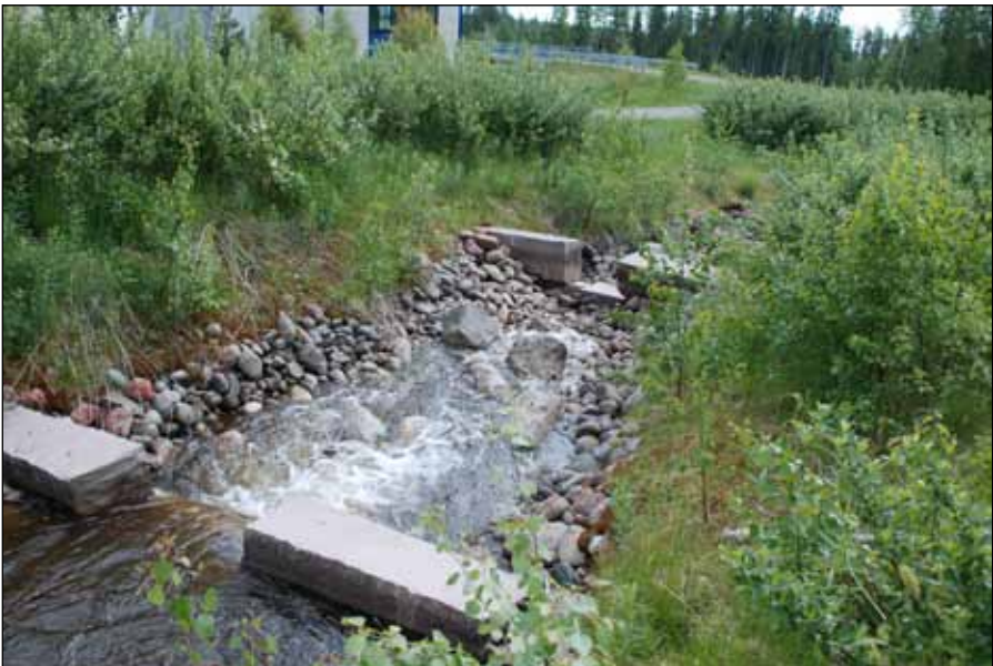
Bilde 2. Naturlig omløpskanal ved Sagnfossen i Trysilelva.
