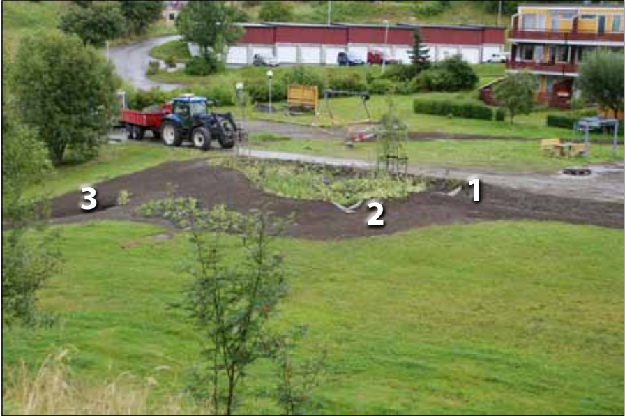
Figur 2. Nyanlagt regnbet på Risvollan; innløp til høyre (1), overløp midt på (2) og drensutløp til venstre (3). Foto Arvid Ekle
