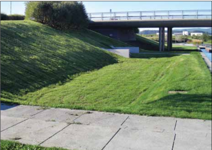
Figur 5. Rensedam (over) og rensefilter (under) for rensing av vegvann (Foto: Åstebøl, COWI)
