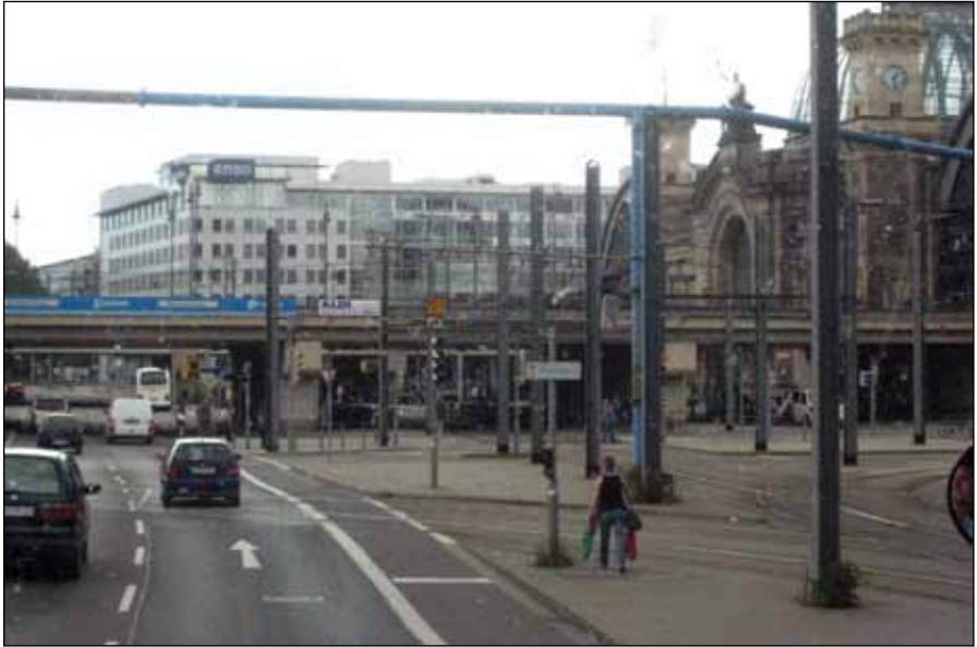
Figur 3. Vannledninger er hengt opp i luften (Foto: S. T. Thorolfsson).
