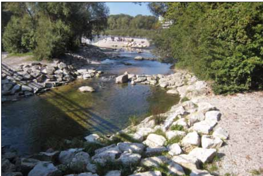
Figur 5. Terskler i elven som holder på vannet, danner kulper, og gir miljø for fisken til å vandre opp (Foto: S. T. Thorolfsson).
