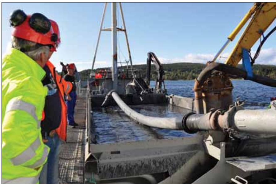
Utlegging av aktivt kull og leire i blanding som tynntildekking på forurenset sjøbunn. Foto: Klif
