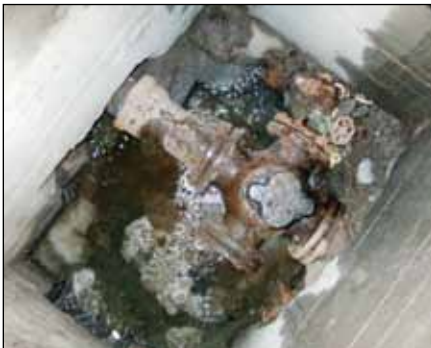
Figur 4. Eksempel på felleskum før rehabilitering (Foto: Asplan Viak as).
