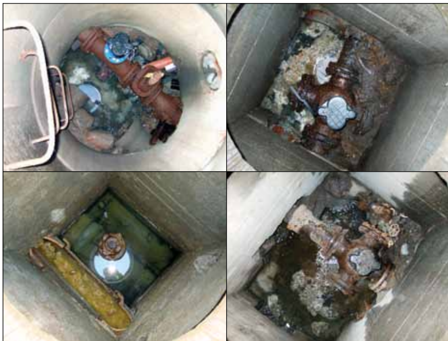
Figur 1. Eksempler på felleskummer med åpen kloakkrenne og vannledning med brannventil (Foto: Asplan Viak as).
