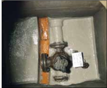
Figur 5. Eksempel på samme kum etter rehabilitering (Foto: NoDig NOR as).
