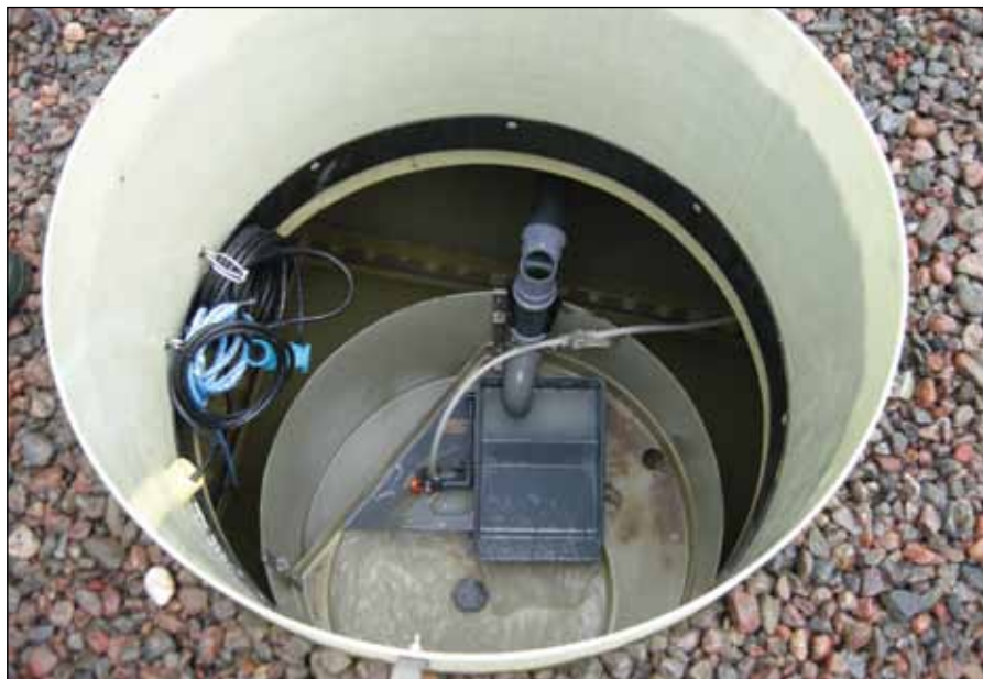
Bild 1. Wallaxverk med doserventil och vippskopa för kemikaliedosering (Foto: Maria Hübinette).
