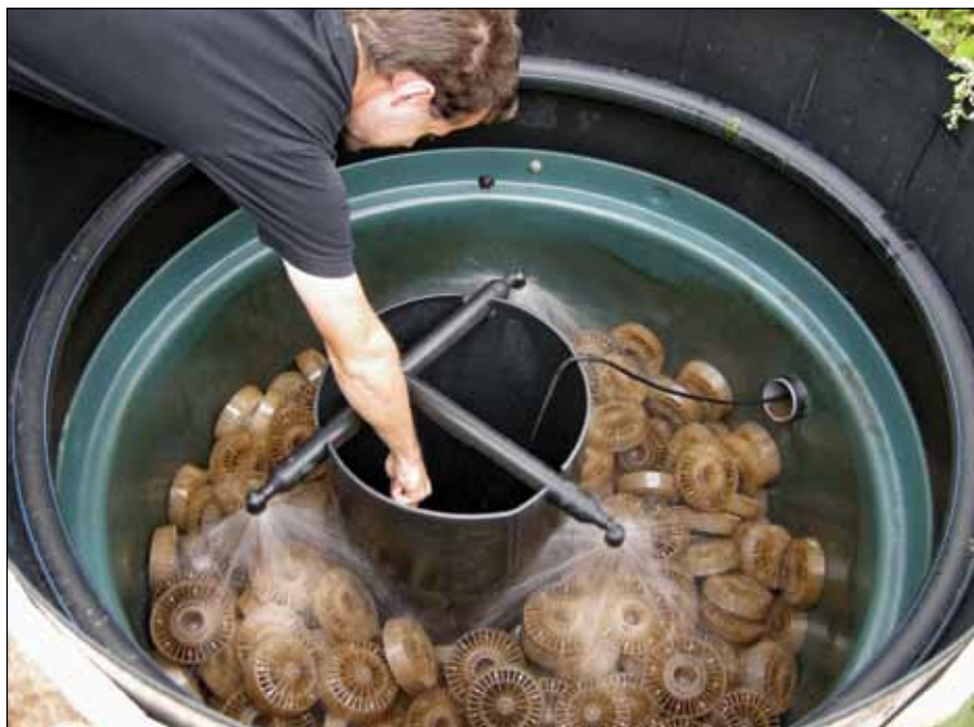
Bild 4. Green Rock. Lite svært å nå, men annars går dessa anläggningar bra att provta. Många modeller av minireningsverk är betydligt svårare att provta! (Foto: Maria Hübnette).
