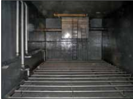
Figur 6. Luftesystem og utløpssiler i Kaldnes MBBR.
