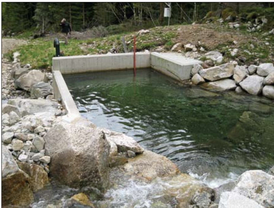
Illustrasjon 4. Inntaksdam hjå Myklebustdalen Energi i Kvinnherad. Dette enkle inntaket har fungert etter føresetnaden.
