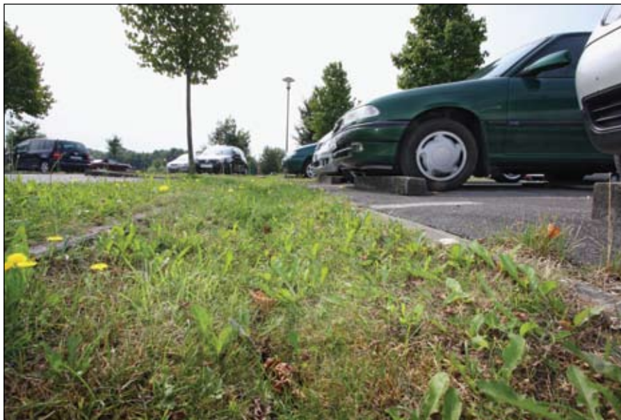
Figur 7. Vandet strømmer her fra parkeringen til små grønne render, og videre til et bassin, hvis det ikke kan nå at sive ned. Foto© ved forfatteren.
