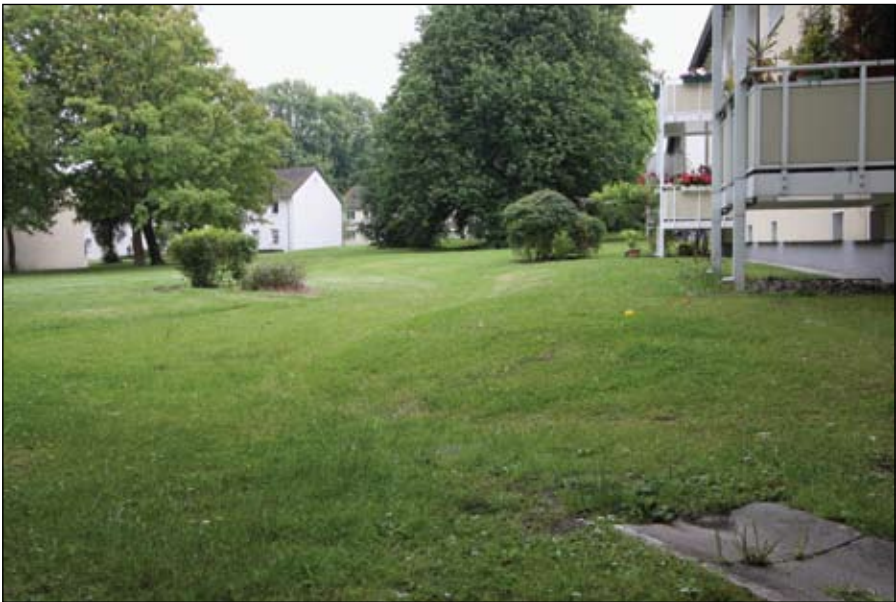
Figur 4. Enkel regulering af terrænet mellem boligblokke, så alt vand her magasineres og nedsives. Foto© ved forfatteren.
