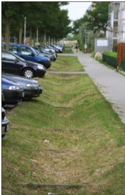
Figur 5. Grøfterne opsamler og nedsiver vandet fra gang-, parkerings- og vejarealer. Grøften er opdelt i sektioner, så alt regnvandet opsamles. Ekstra store vandmængder går i et forhøjet overløb og løber til anden nedsivning og forsinkelse. Foto© ved forfatteren.
