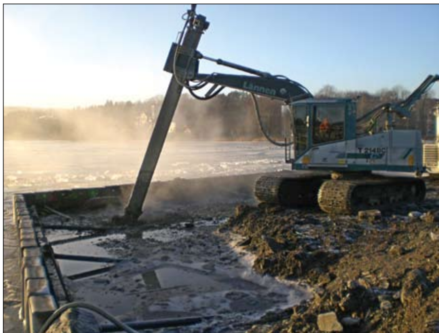
Figur 3. Bildet viser innblanding av masser for stabilisering helt syd på anlegget.
