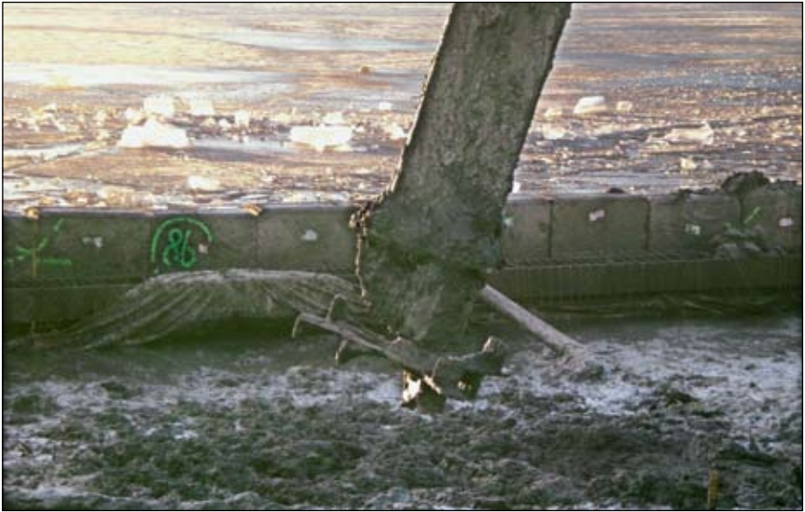
Figur 4. Verktøyet som ble benyttet til innblandingen.
