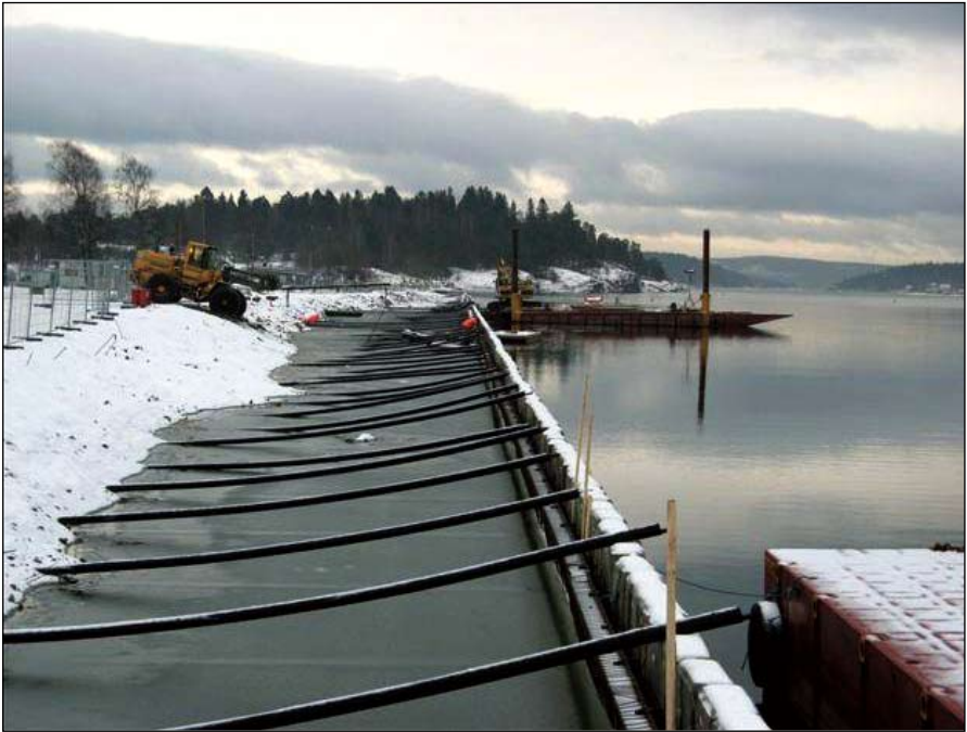
Figur 2. Gropen bak spunten før oppfylling.
