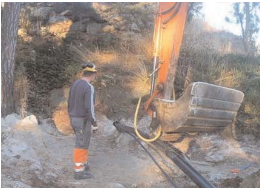
Figur 1. Fra arbeidet med å føre frem vann- og avløpsledninger.
