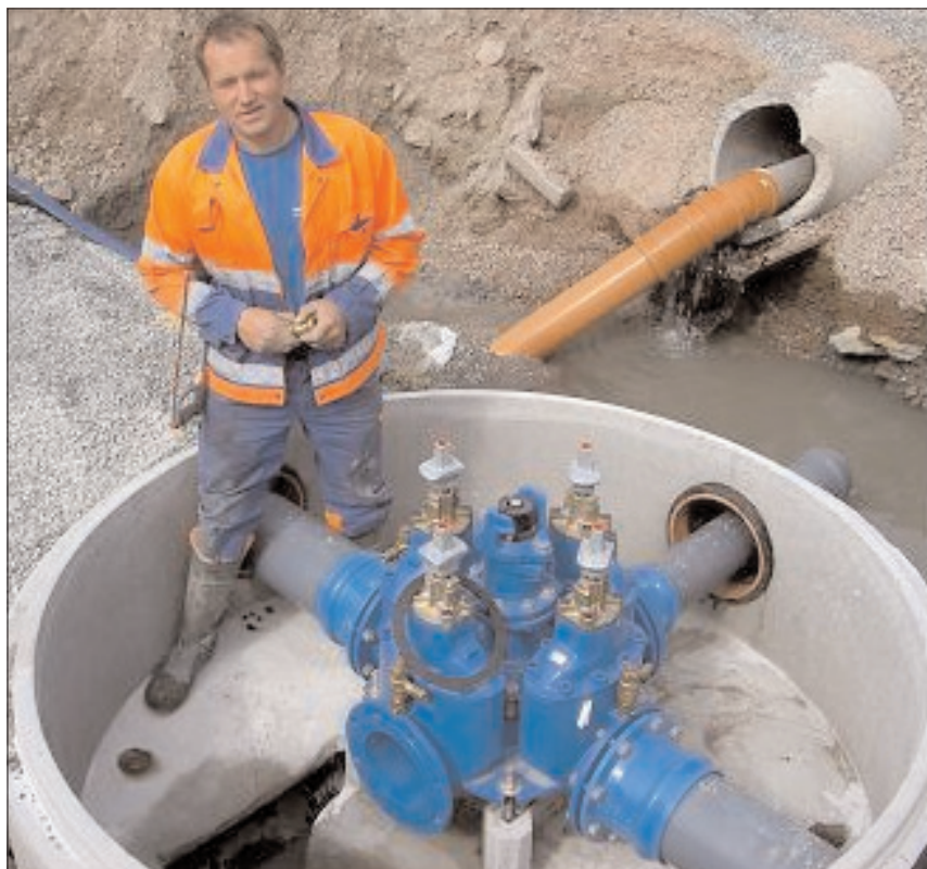
Figur 2. Et eksempel på at moderne vannkummer bygges med fokus på gode arbeidsforhold og høy hygienisk sikkerhet.
