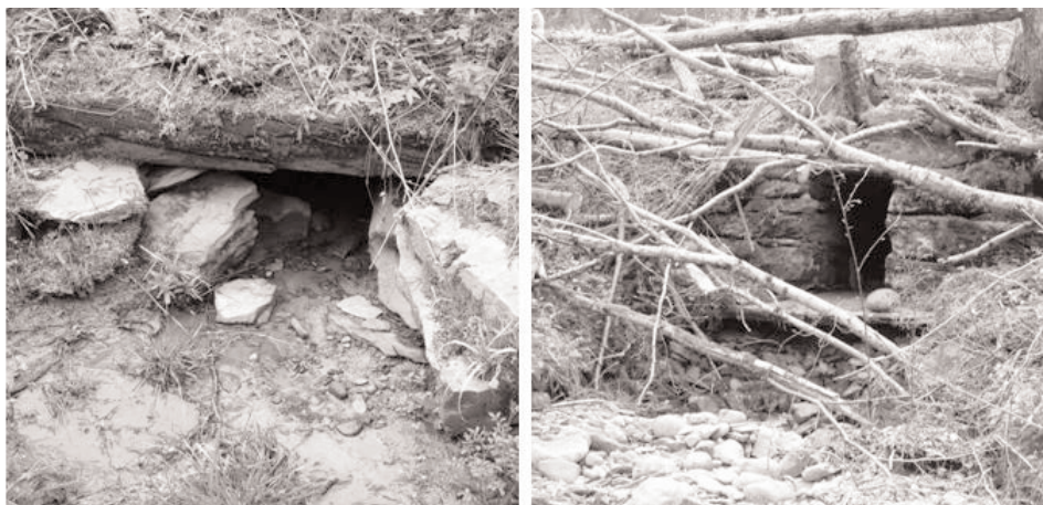
Figur 6. Innløp og utløp til km 54,912 pr. mai 2008.
