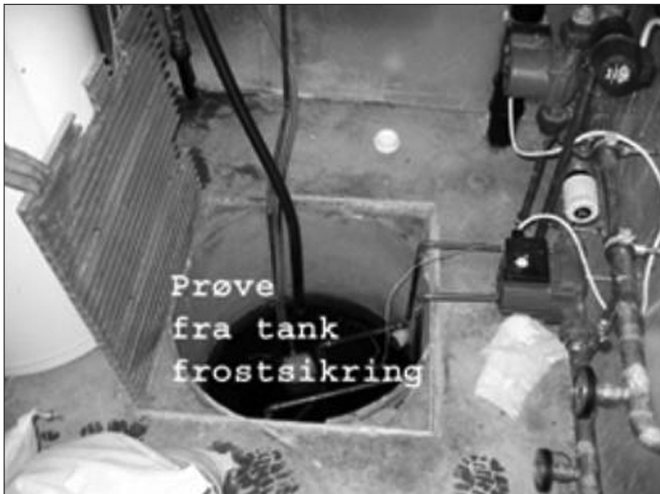
Figur 3. Resirkulasjon frostsikring selvvaskeanlegg
