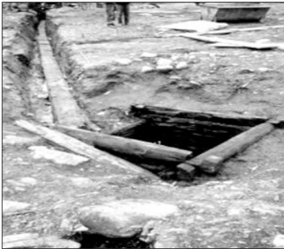
Bildet viser en gammelbrønn for vannpost og datidens treledninger (foto: Trondheim kommune).
