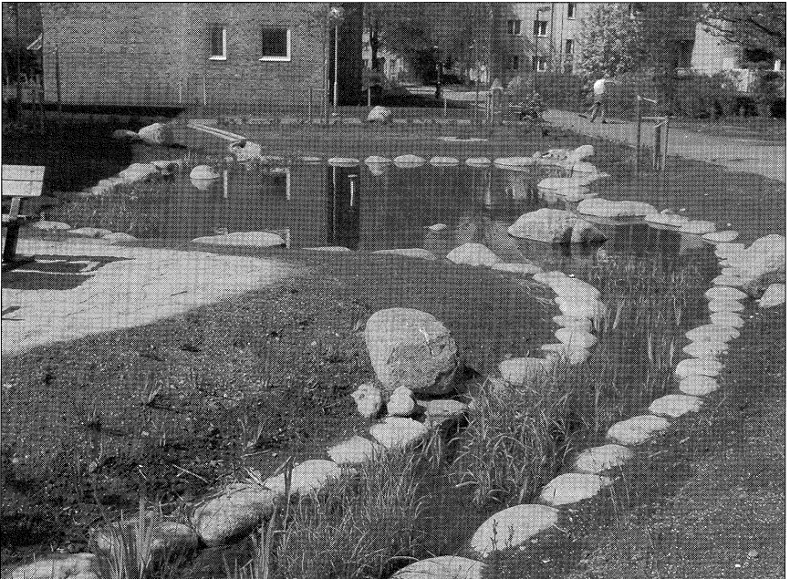
Nybygd åpen overvannsløsning i et boligområde
