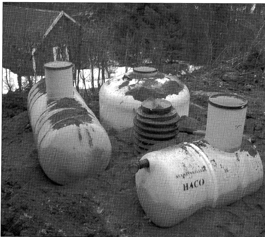
Kompaktfilter for gråvann, boligmodell, i kombinasjon med tett tank for svartvann
