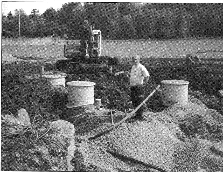
Rørleggermester Henning Marcussen under monteringen av et Wallax avløpsrensanlegg på Veierland, Nøtterøy kommune
