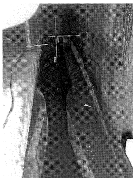
Bilde 2: Målerenne med nivåmåler
